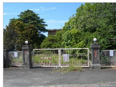
旧住吉浄水場正門
